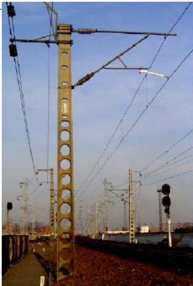
4—吊弦 5—承力索 6—基础 7—支柱 10—接触线 11—坠砣
